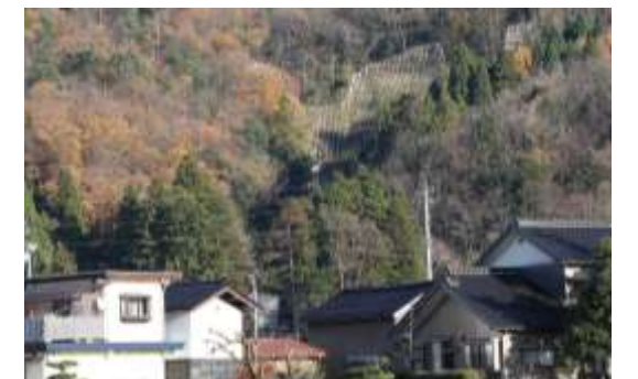
治山施設の整備(魚津市東山)
