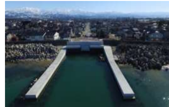
河川(放水路)の整備(沖田川放水路)
