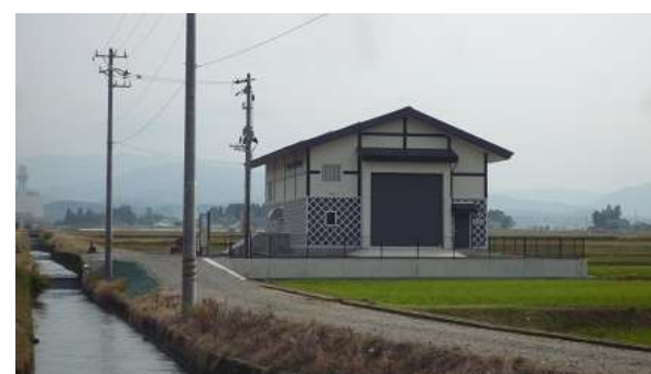
農業用水を活用した 仁右エ門用水発電所
