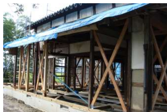
住宅の耐震改修工事
