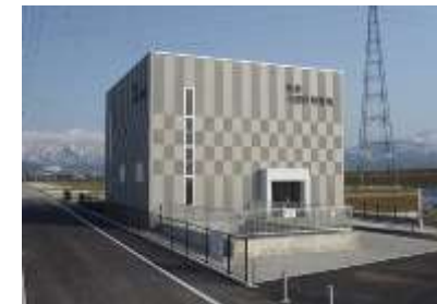
農業用水を活用した小摺戸発電所 入善町、出力370kW (県企業局)
