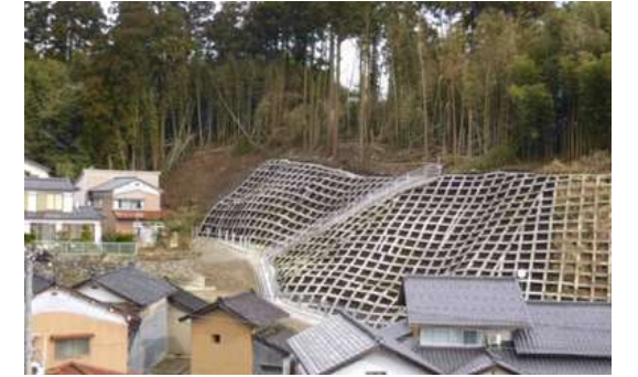
急傾斜地崩壊防止施設の整備(氷見市朝日丘地区)
