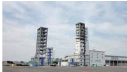
富山県広域消防防災センター 主訓練塔(高さ45m)
