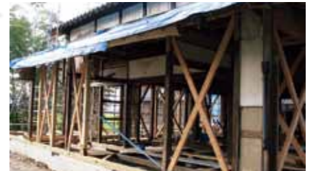
住宅の耐震改修工事
