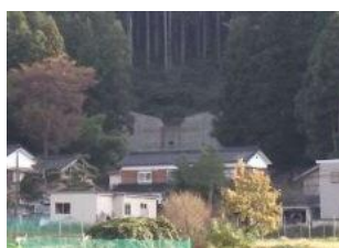
砂防堰堤の整備 (魚津市長引野東谷)
