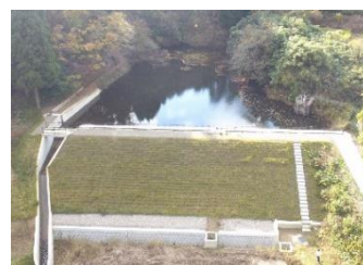
整備済みのため池
