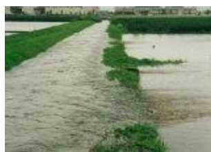
溢水被害防止対策前
