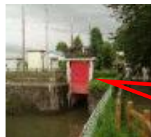
老朽化状況（松川水門）
