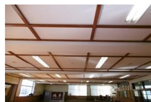
天井落下防止対策
