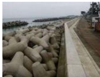
護岸改良・ブロック嵩上げ
