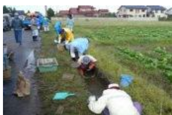
水路の目地補修
