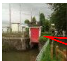
老朽化状況（松川水門）
