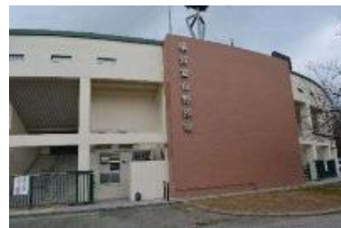
公園施設の機能維持（県営富山野球場）
