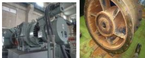
排水ポンプの補修
