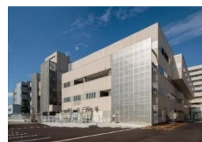
県立中央病院 先端医療棟
