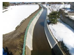
長寿命化対策後
