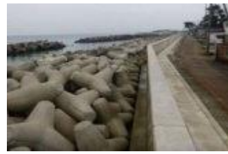
護岸改良・ブロック嵩上げ
