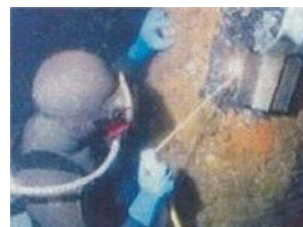
港湾岸壁の防食機能維持
