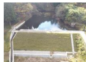
整備済みのため池
