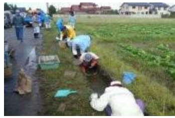
水路の目地補修
