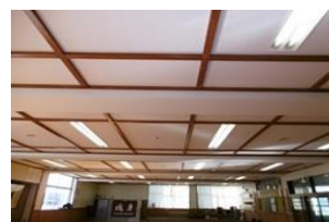
天井落下防止対策
