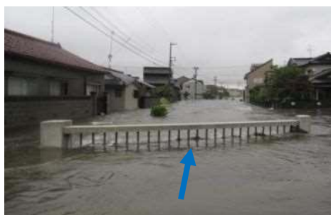
H24出水状況 (地久子川)
