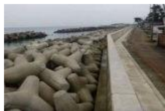
護岸改良・ブロック嵩上げ
