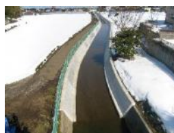
長寿命化対策後
