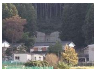
砂防堰堤の整備 (魚津市長引野東谷)
