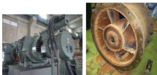
排水ポンプの補修
