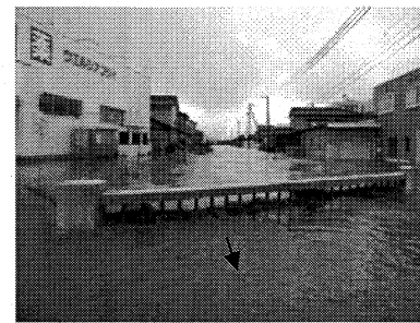
地久子川(高岡市)(平成24年7月豪雨による浸水状況)
