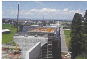
国道359号砺波東バイパス 工事進捗状況
