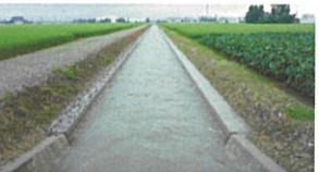
国営附帯県営農地防災(庄川左岸地区) 改修後の狐島用水路(砺波市)
