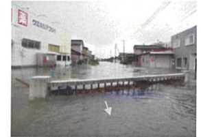
地久子川(高岡市) (平成24年7月豪雨による浸水状況)
