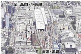
富山駅付近連続立体交差事業
