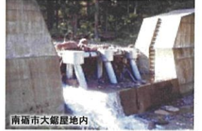
南砺市大笹屋地内 流木対策の実施(流木を捕捉した治山ダム)
