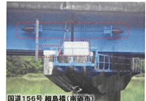
国道156号 細島橋(南砺市) 橋梁の耐震化(補強状況)
