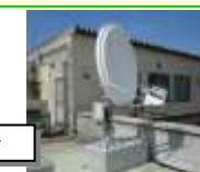
県庁屋上アンテナ
