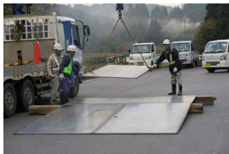
避難ルートへの応急復旧作業（段差解消） (氷見市 国道415号 谷屋地内)
