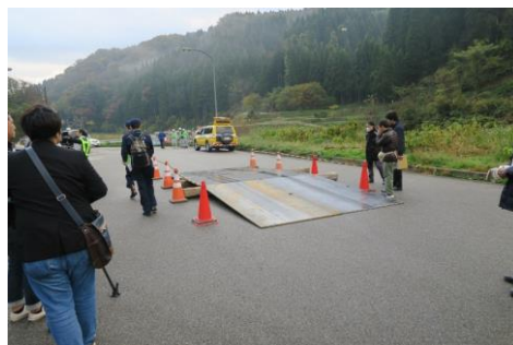
避難ルートへの応急復旧完了（段差解消） (氷見市 国道415号 谷屋地内)
