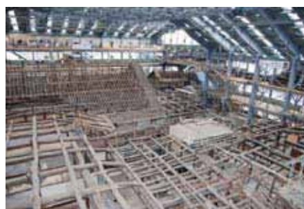
保存修理が進む勝興寺本坊
