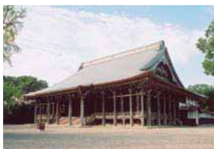
国指定重要文化財「勝興寺」本堂
