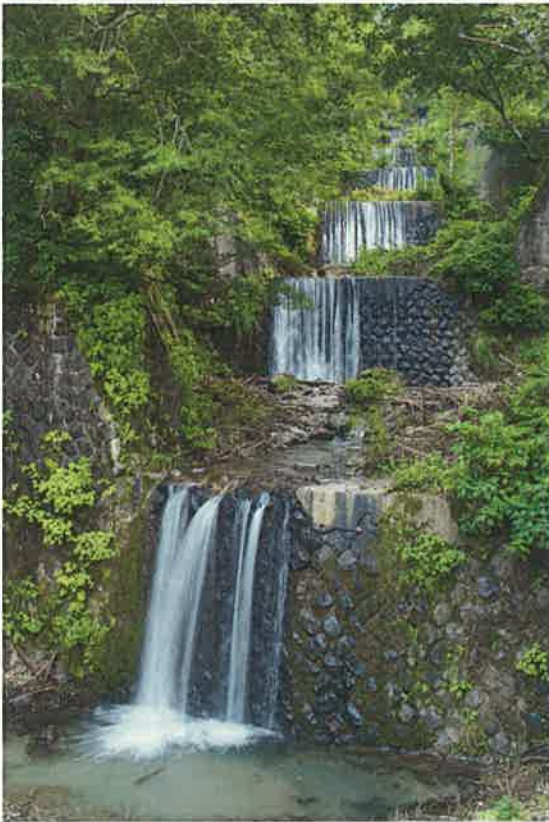
階段式の堰堤
