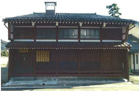
滑川市 有隣庵（旧土肥家住宅）主屋
