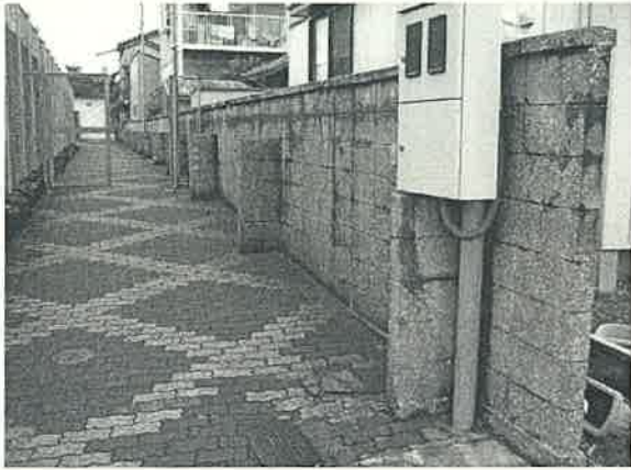
【高岡西高校 テニスコート北側境界 ブロック塀】
